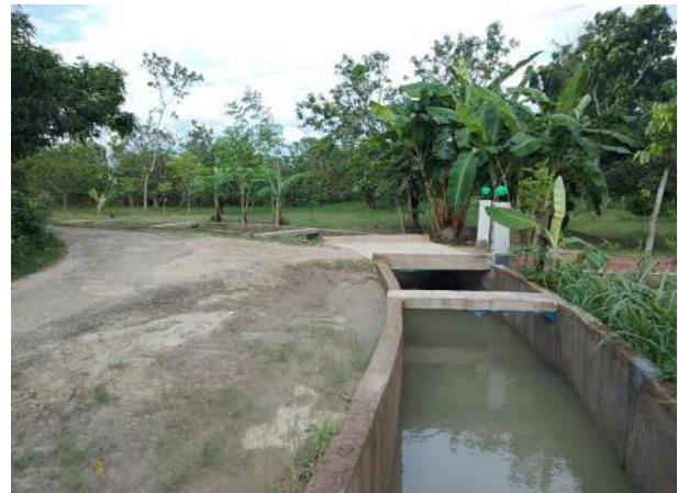
চিত্র-৬: চারঘাট উপজেলার মেরামতপুর এলাকায় আরসিসি রিটেইনিং ওয়ালসহ কালভার্ট নির্মাণ
