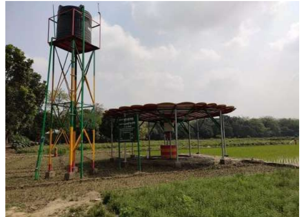
চিত্র-৭: খননকৃত পাতকুয়ায় সোলার প্যানেল স্থাপন করে সেচাবাদ। (উপজেলা : পুটিয়া, মৌজা: মাহেন্দ্রা)
