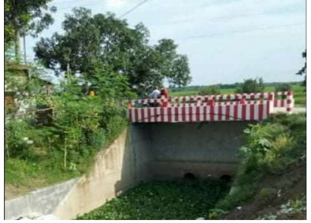
চিত্র-৮: বাঘা উপজেলায় খালের পাড় ও পাকা রাস্তা রক্ষার্থে আরসিসি ড্রেন এবং ফুটওভার ব্রিজ নির্মাণ
