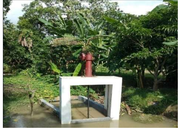
চিত্র-৪: খননকৃত খালের মাধ্যমে বিলের জলাবদ্ধ পানি অপসারণের জন্য পদ্মা নদীর তীরে স্লুইচগেট নির্মাণ (উপজেলা: চারঘাট, মৌজা: পিরোজপুর)
