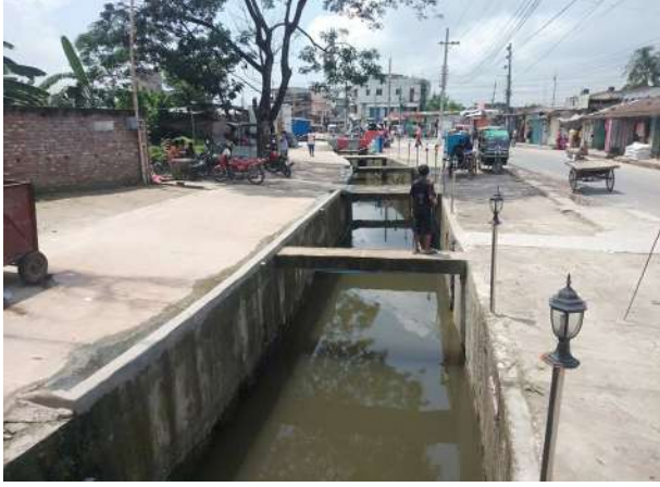
চিত্র-৭: পবা উপজেলার কাটাখালী খালে পাকা রাস্তা রক্ষার্থে আরসিসি ড্রেন নির্মাণ
