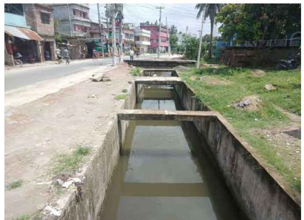
চিত্র-৬: কাটাখালী এলাকায় খালের পাড়ে অবকাঠামো রক্ষার্থে রিটেইনিং ওয়াল নির্মাণ।
