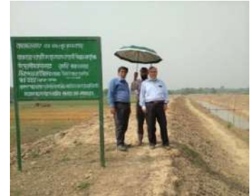
নির্বাহী পরিচালক মহোদয়, বিএমডিএ কর্তৃক খাল পুনঃ খনন কাজ পরিদর্শন
