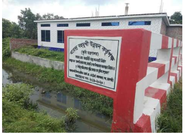
চিত্র-৪: পুনঃখননকৃত খালে নির্মিত রিটেইনিং ওয়াল ও বঙ্গ কালভার্ট নির্মাণের চিত্র।
