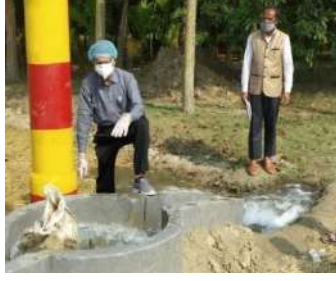
প্রকল্প পরিচালক কর্তৃক ভূ-গর্ভস্থ সেচ নালা নির্মাণ কাজ পরিদর্শন
